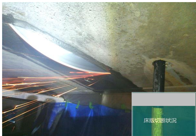
床版切断時の下面の状況
