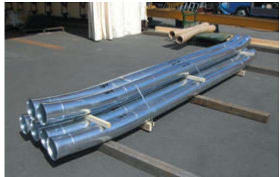
中間支点部及び隔壁においてケーブルを貫通させる管
