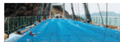
鋼製橋梁床版
