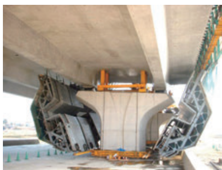
鋼製型枠(移動支保工)
