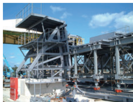
鋼製型枠(プレキャストセグメント)
