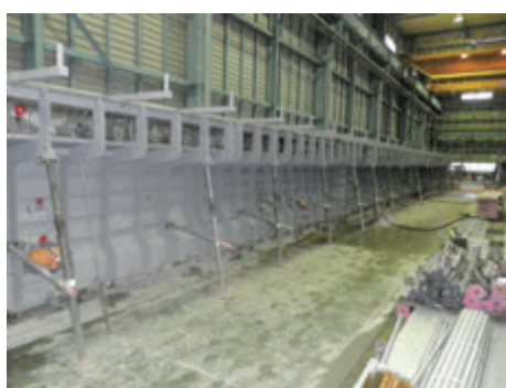
鋼製型枠(セグメント桁)
