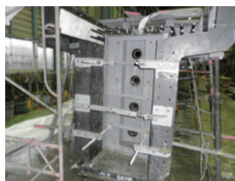
鋼製型枠(セグメント桁)
