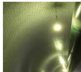
トンネル壁面
