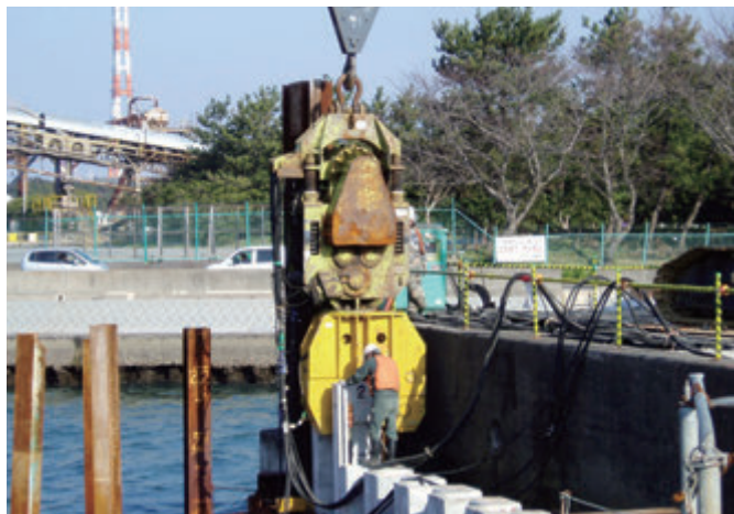
PC矢板 施工
