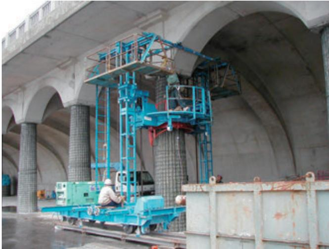
P C 鋼線巻き付け機 (柱補強)
