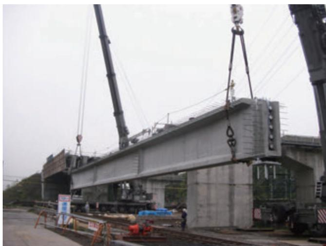
PC桁架設（レッカー架設）
