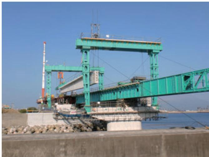
PC桁架設（一組桁架設機）
