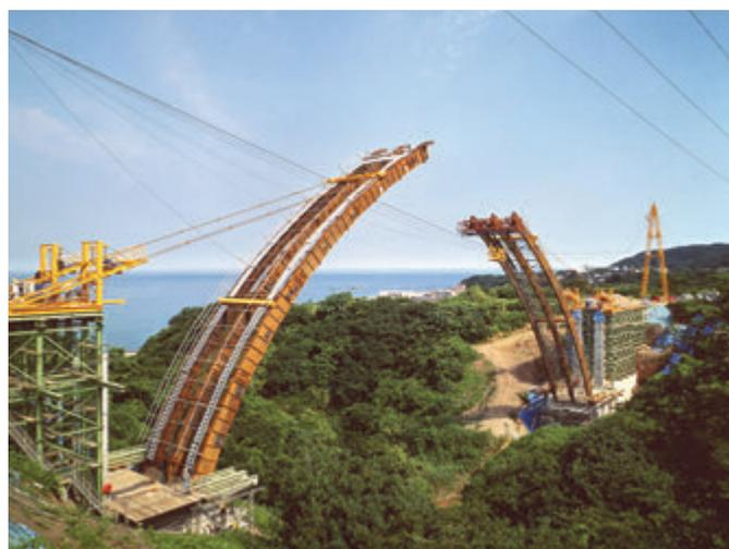
鋼構造物据付（アーチ部材の架設）
