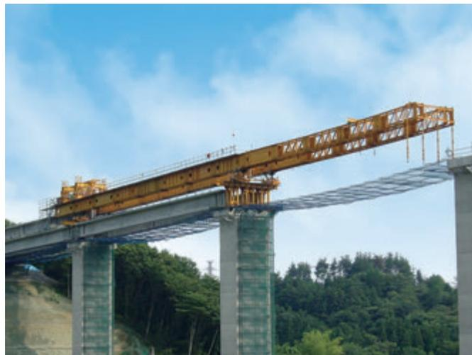
PC桁架設（二組桁架設機）
