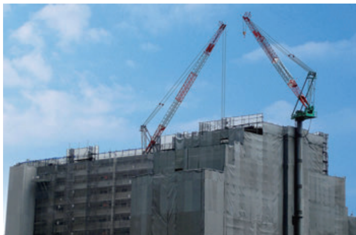
仮設機材全般
