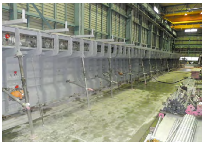
鋼製型枠(セグメント桁)
