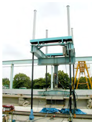
載荷試験装置
