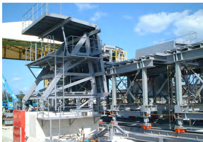
鋼製型枠(プレキャストセグメント)
