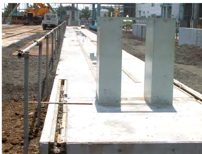
コンクリート製アバット本体、固定ポスト(緊張側)
