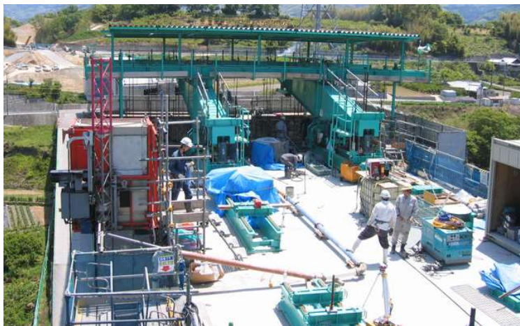
一般的な打設状況
