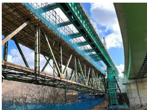
二組桁を用いたトラス橋の解体
