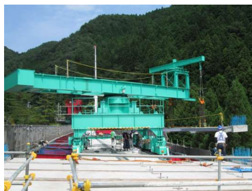
旋回式プレキャスト床版架設機
