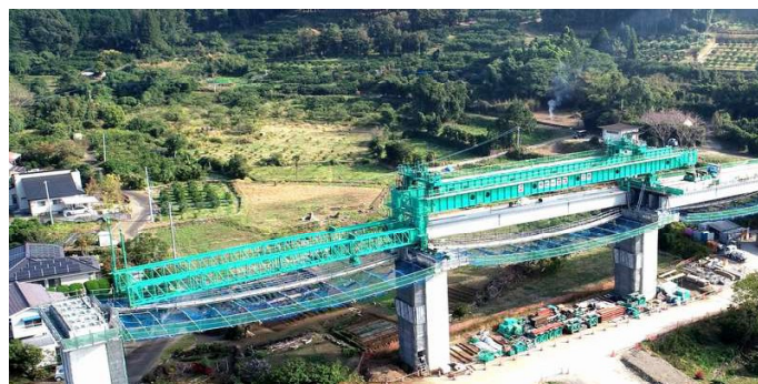
二組桁架設備
