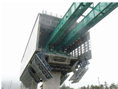
箱桁橋のための移動支保工
