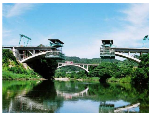
アーチ橋のための移動作業車
