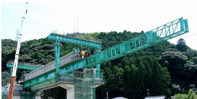
上路式架設桁架設備
