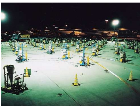
空港舗装のリフトアップ
