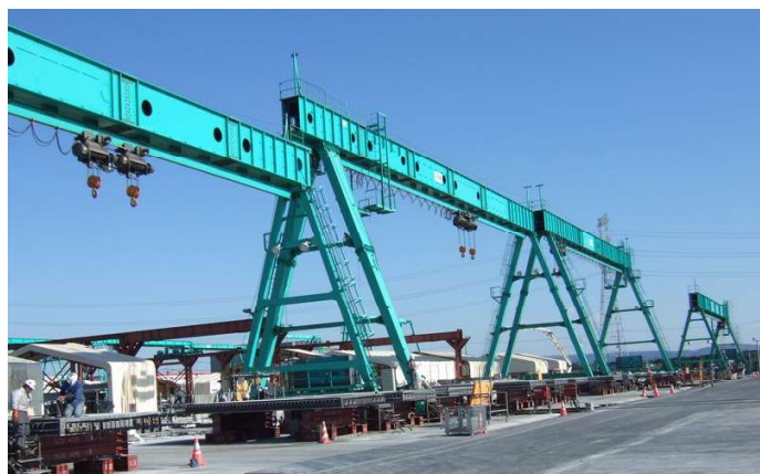
橋形クレーン
