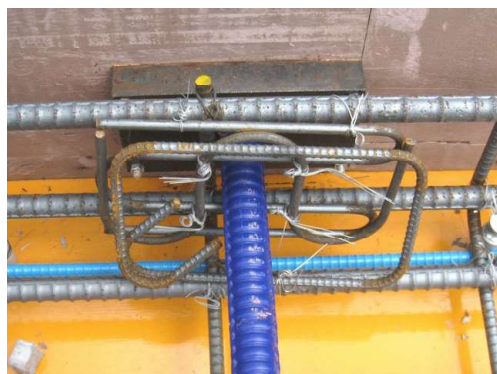
支圧板とグリッド筋
